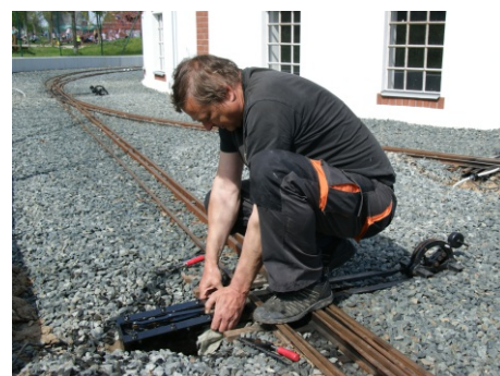
Odborná montáž elmot. přestavníku
