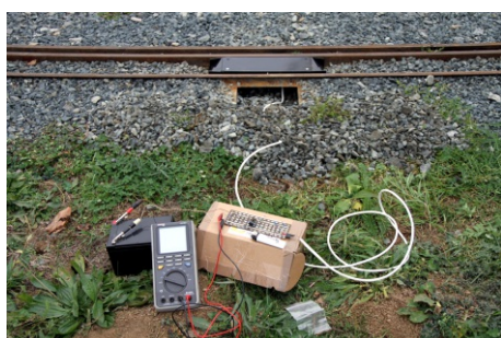
Testování bodu počítače náprav
