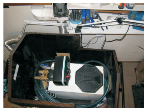
Vnitřek úpravny vody
