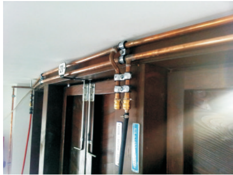
Rozvody vzduchu a vody
