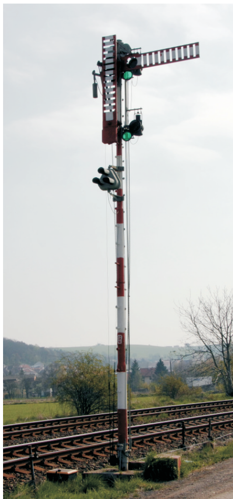
Vjezdové dvouramenné návěstidlo, ještě v Bučovicích
