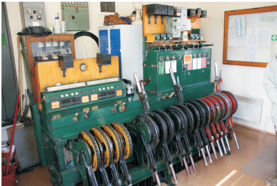
Stavědlový přístroj, krajní dvě páky jsou ty naše.
