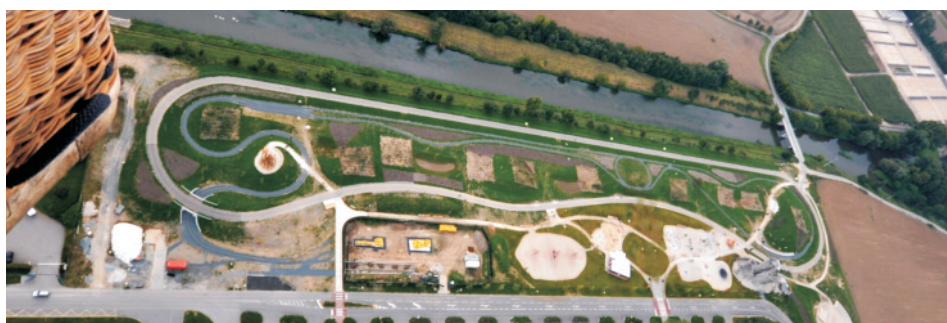
Letecký snímek ze září 2010 ukazuje trať (šedý pruh) a zatím prázdné nádraží
