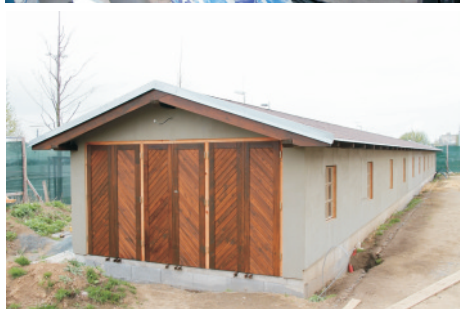
Fotky shora - výpravní budova, dílna, dílna uvnitř, vozové depo
