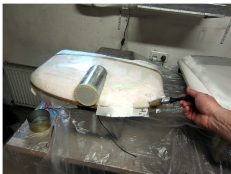
Laminování střešního dílu
